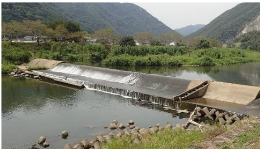
写真1 当初の堰の様子
