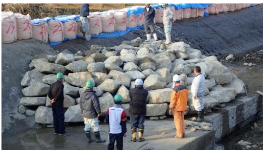
写真2 石組み魚道の設置
