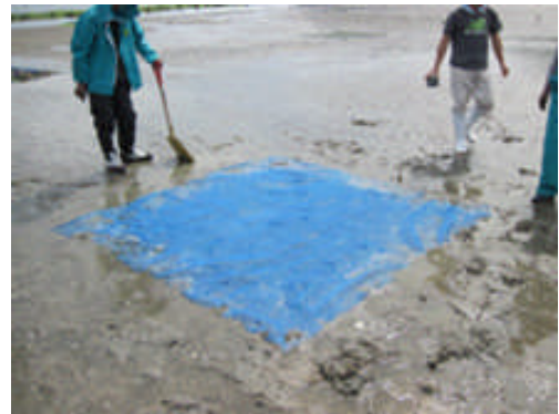
図2 かぶせ網の設置状況
