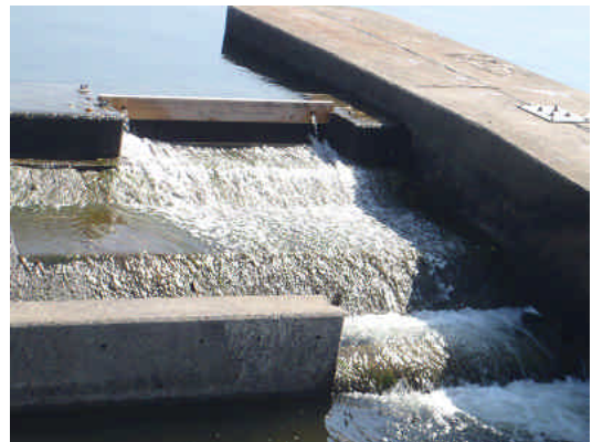
写真2 分枝板設置後
