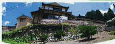
地すべりにより石垣が変形 <(地)畑ノ上地区(高梁市)>
